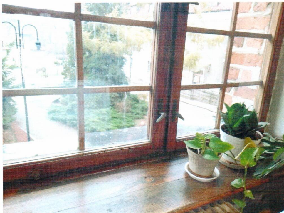
Odnowienie dwóch parapetów drewnianych
